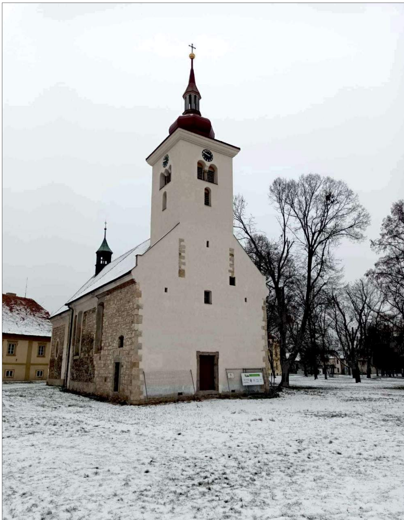
Dokončování záchrany kostela sv. Šimona a Judy v Lenešicích.
